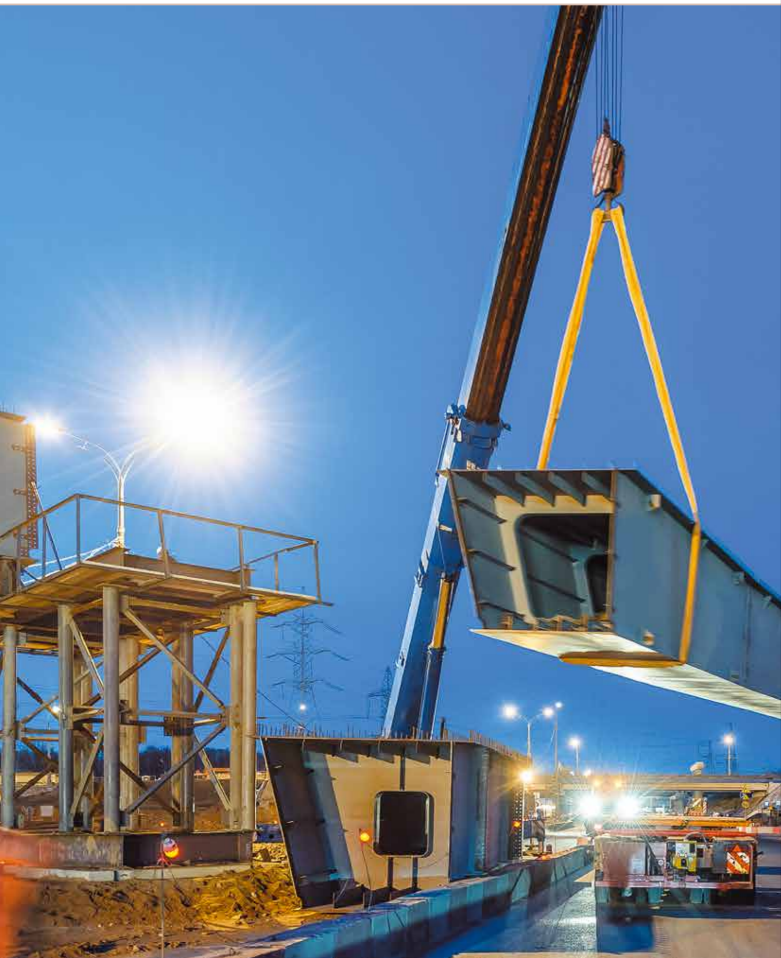
Монтаж пролетного строения эстакады г. Москва, МКАД работа автокранов Liebherr LTM 1200 и Liebherr LTM 1220
