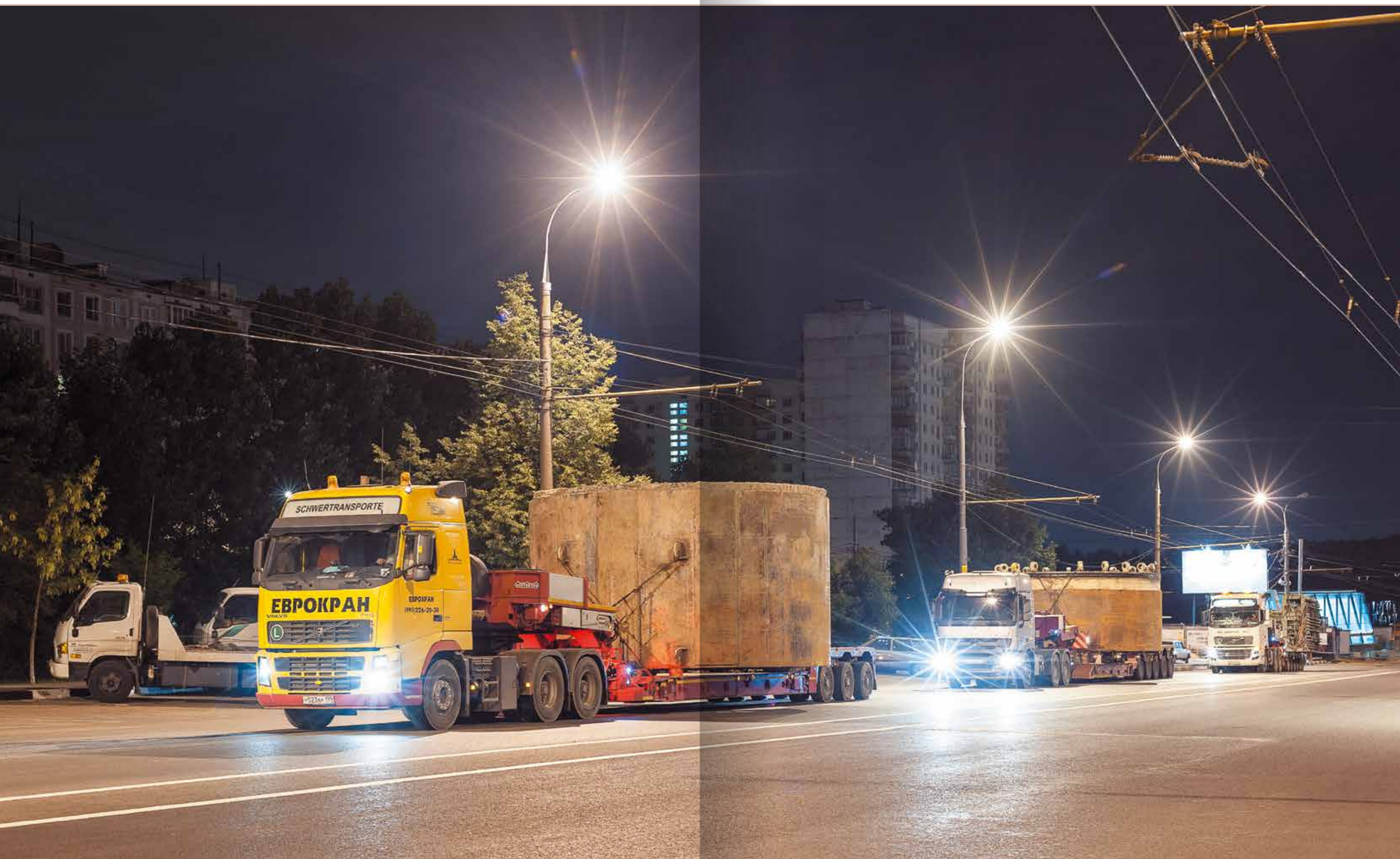
Демонтаж, перевозка и разгрузка проходческого щита Московская область
