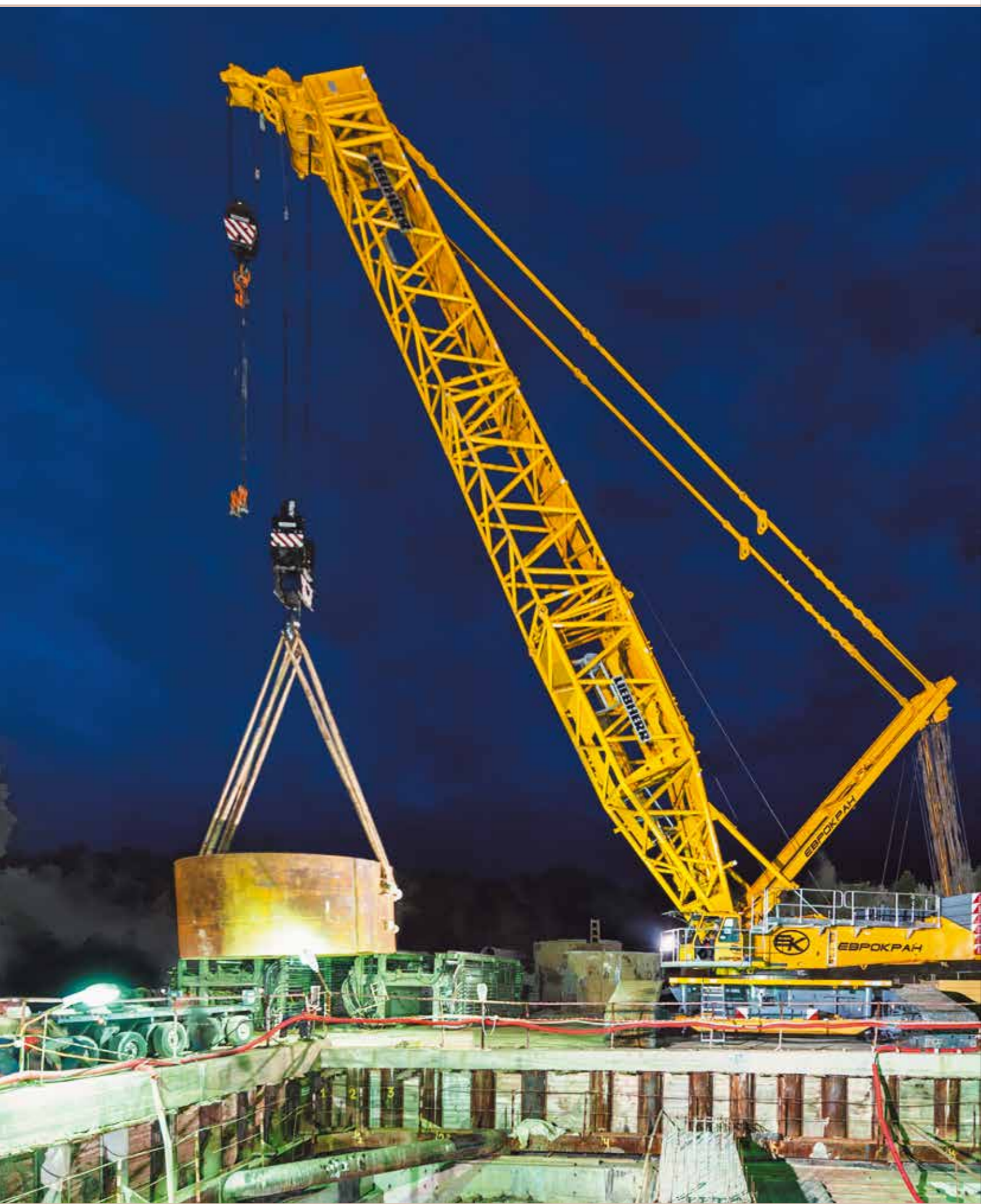
Сборка и монтаж проходческого щита Московская область
