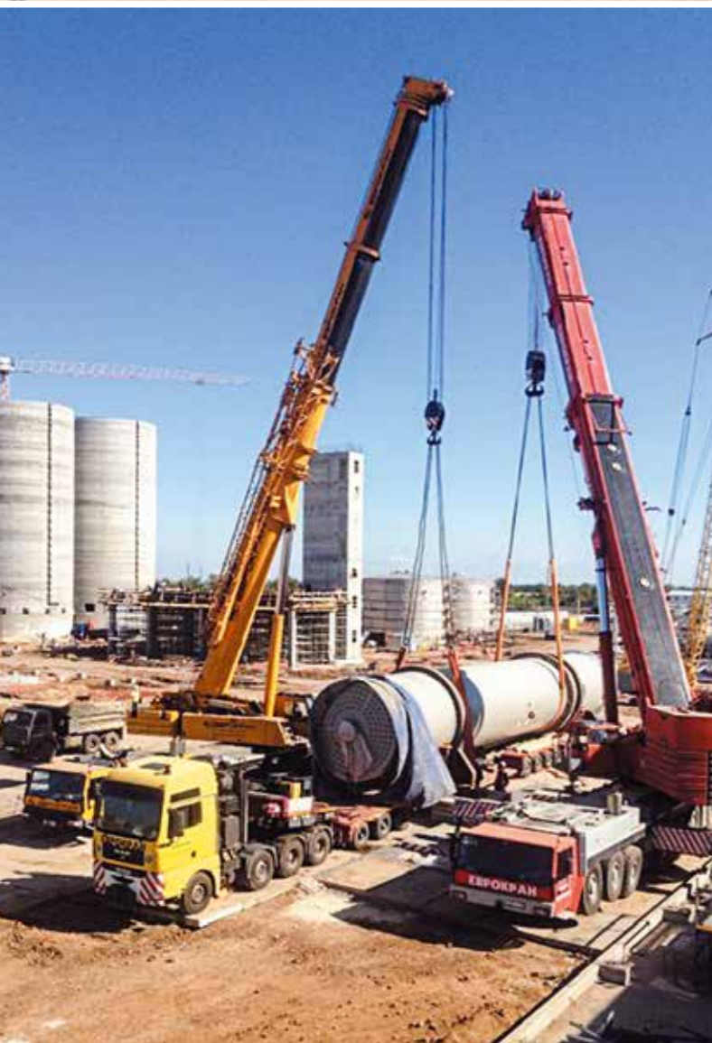
Перемещение и подъем роторного кондиционера весом 131 т. Строительство маслоэкстракционного завода Волгоградская область
