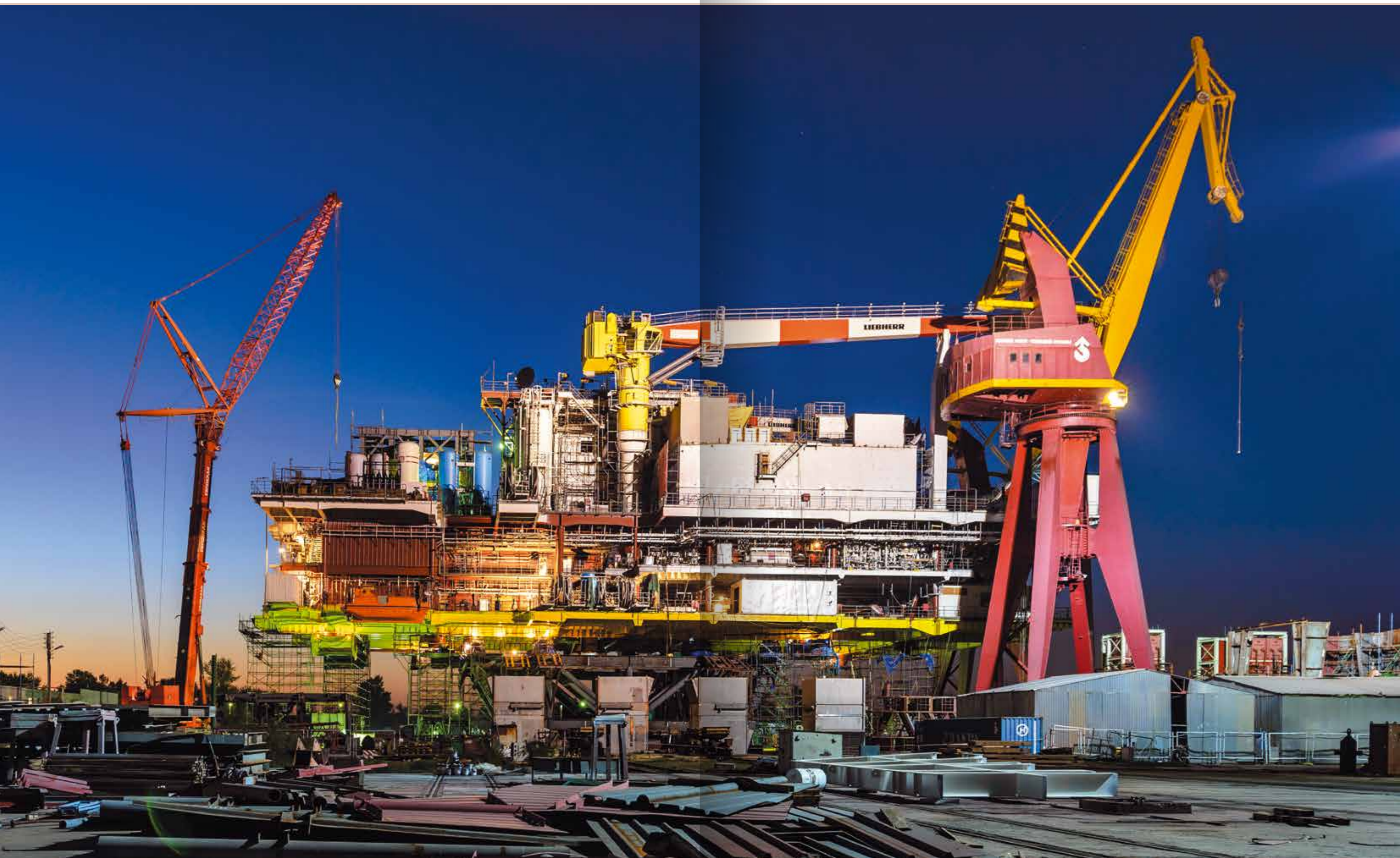
Монтаж нефтяных буровых установок г. Астрахань
