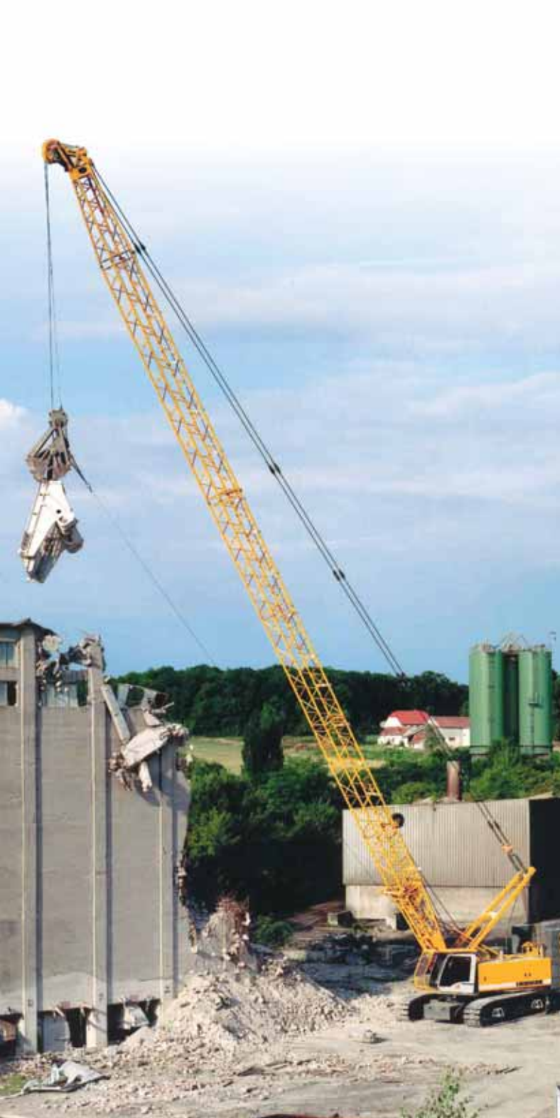
LR 1100 Обрушение сооружений с помощью грейфера, Саарланд (Германия)
