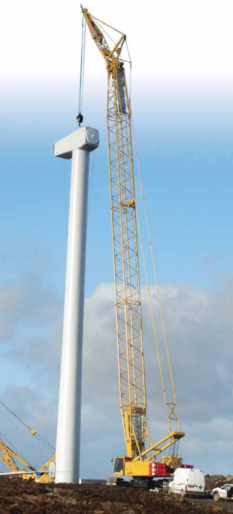
LR 1160 Монтаж ветрового генератора V52, Сгуач Мнор / Шотландия
